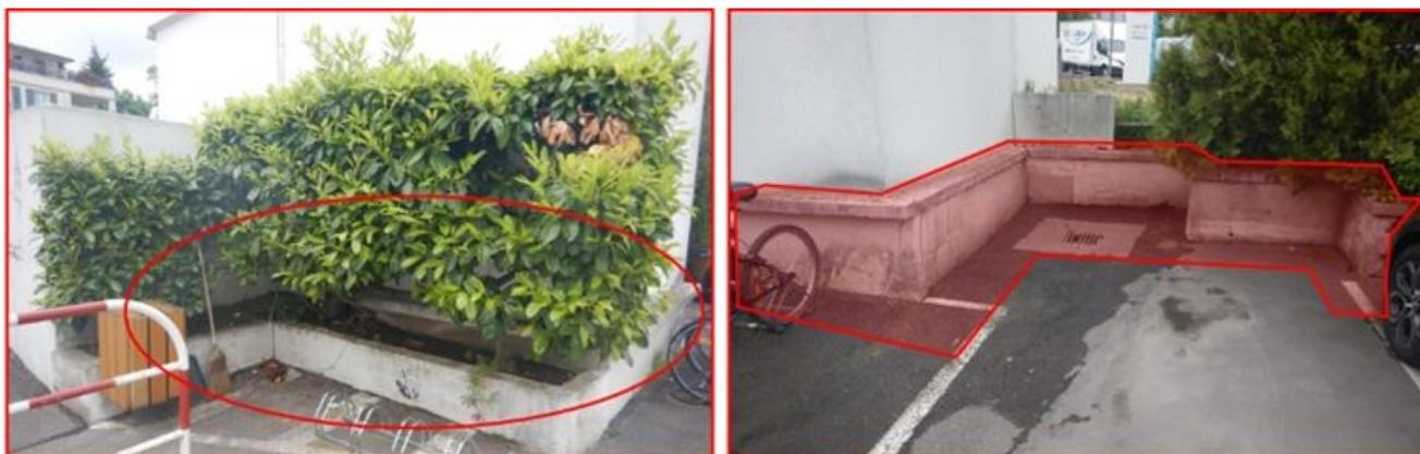
*Vue d'ensemble de la zone située au droit du parking en RDC générant des infiltrations le parking en sous-sol dues à la défaillance de l'étanchéité de la zone.*
